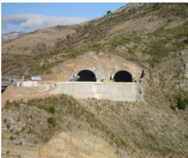
Imbocco galleria di Serra Rotonda
